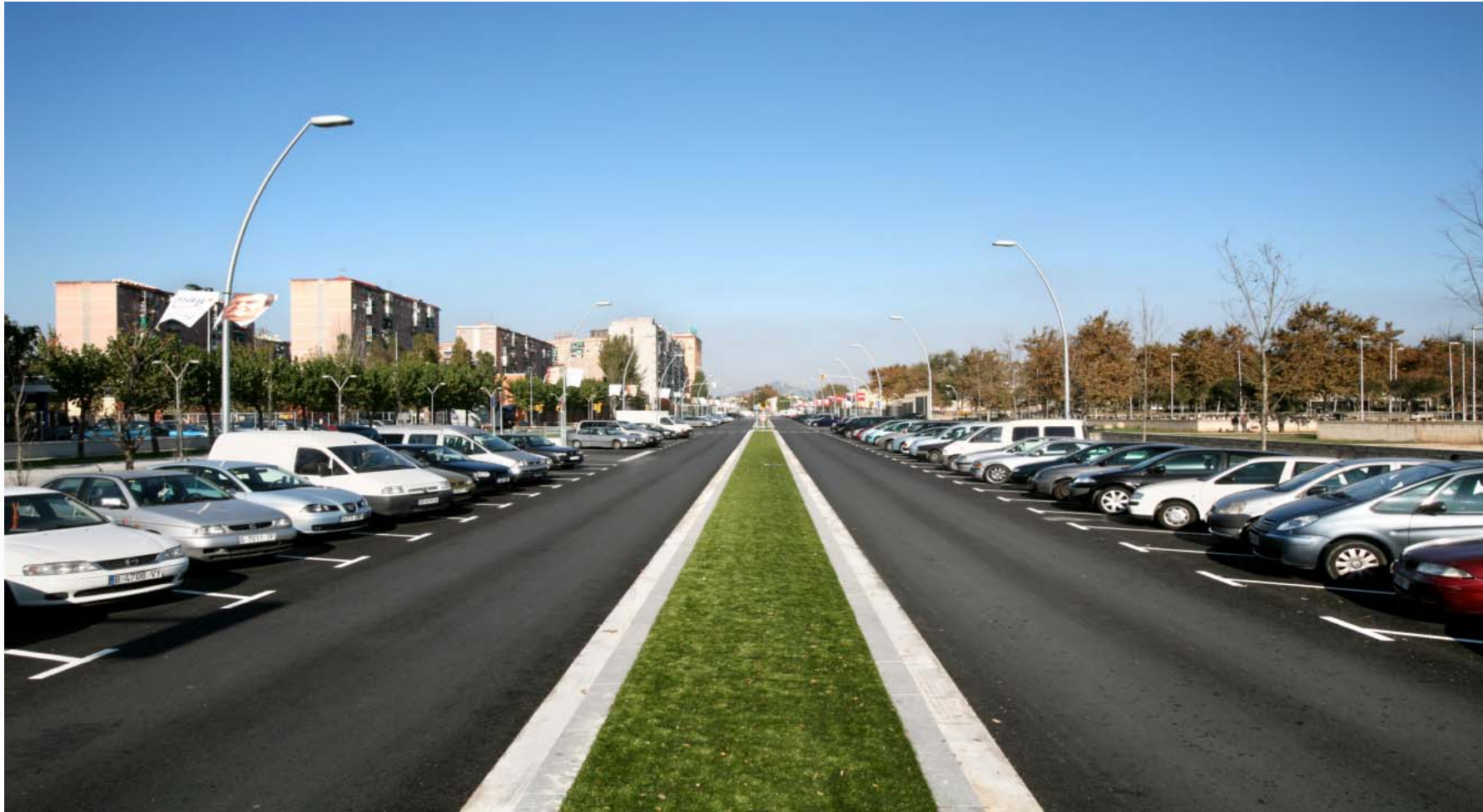
Vista general de l'àmbit d'actuació direcció a Gran Via (15/11/2010)
