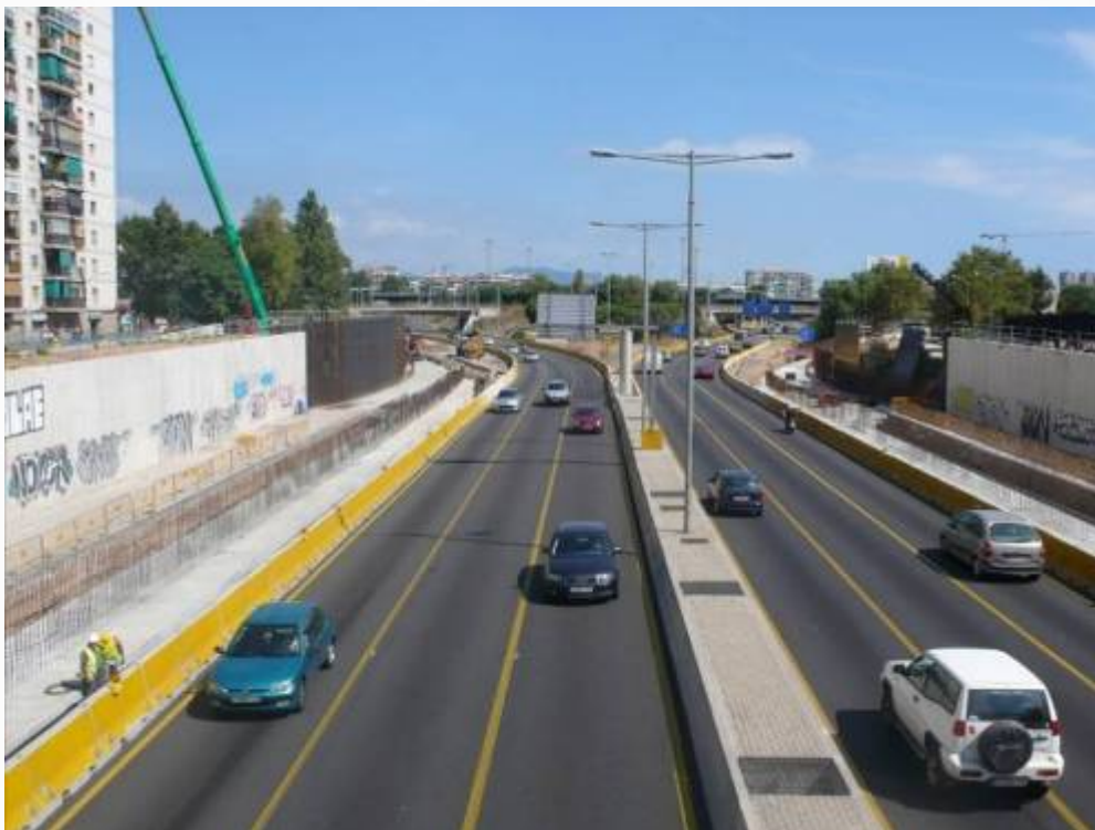
Vista general de l'àmbit d'actuació (14/09/2010)
