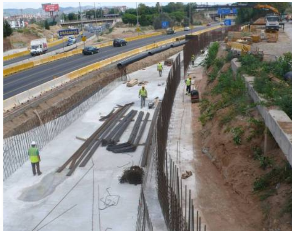
Preparació d'armadura al tronc banda mar (10/09/2010)
