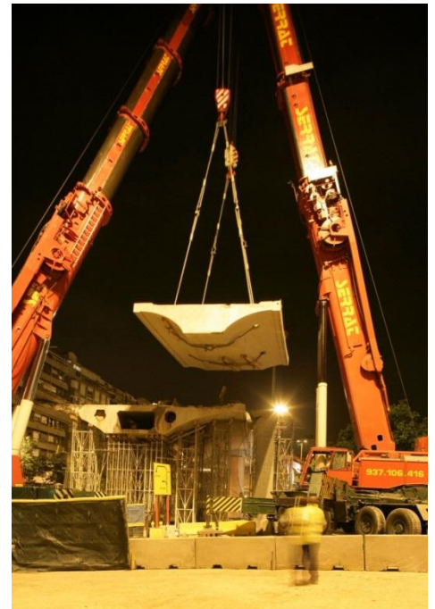
Retirada de peces amb grua
