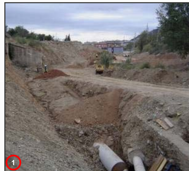
Reblert de canonada d'aigua (20/09/07)
