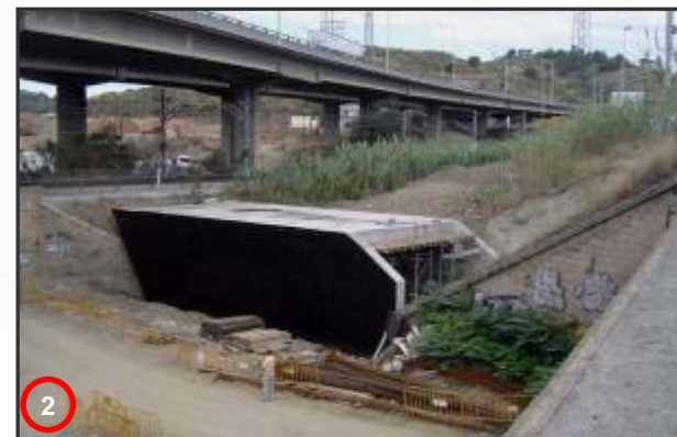
Estructura de "calaix" llesta per a posterior empenyiment (21/08/07)
