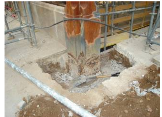
Repicat de la base d'un pilar per a la seva extracció. (Juny '09)
