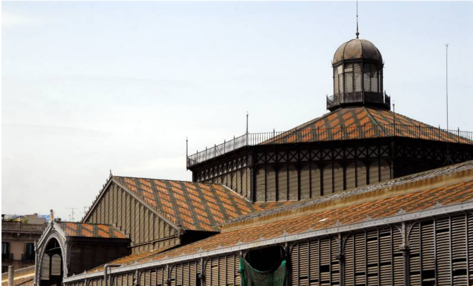
Detall exterior edifici: al fons, cimbori octogonal i llanterna (15/05/08)
