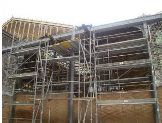
Col·locació del cindri d'estintolament. (Juny '09)
