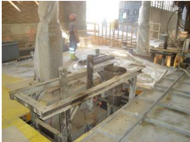
Pont de recolzament de la micropilonadora. (Juny '09)
