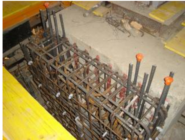
Armat d'encep de 3 micropilons amb els connectors col·locats amb resina epoxi. (Juny '09)
