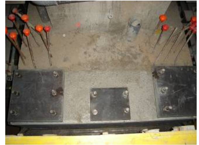
Encep acabat a la espera de la introducció del morter sense retracció sota les plaques metàl·liques. (Juny '09)
