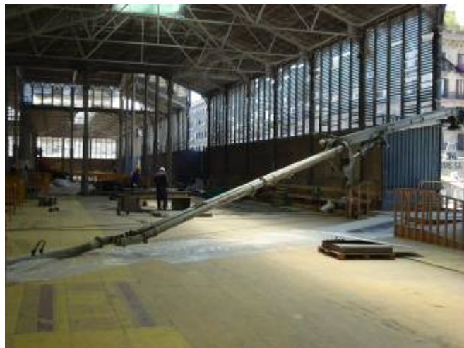
Braç de la bomba de formigó i protecció de la plataforma contra les possibles fugites. (Juny '09)
